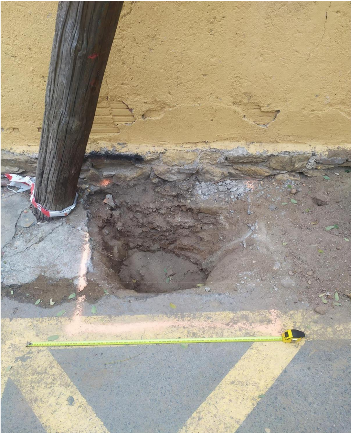
Rasa efectuada a al Passatge Feliu n.º 5 per a la instal·lació d'un embornal.
