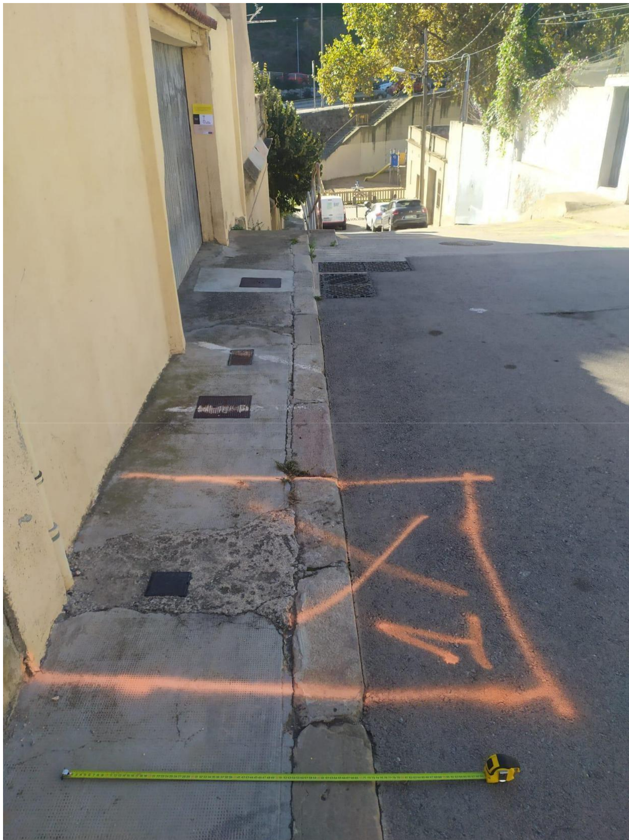
Detall de l'inici d'obertura dels sondejos
