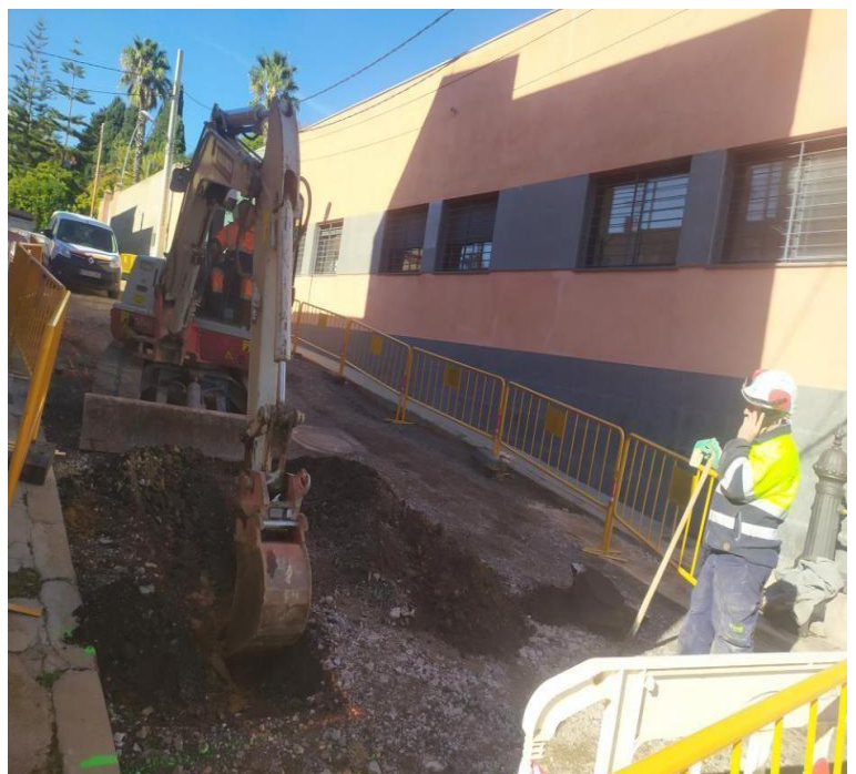
Màquina efectuant un rebaix per a la instal·lació de serveis al Carrer de l'Amor
